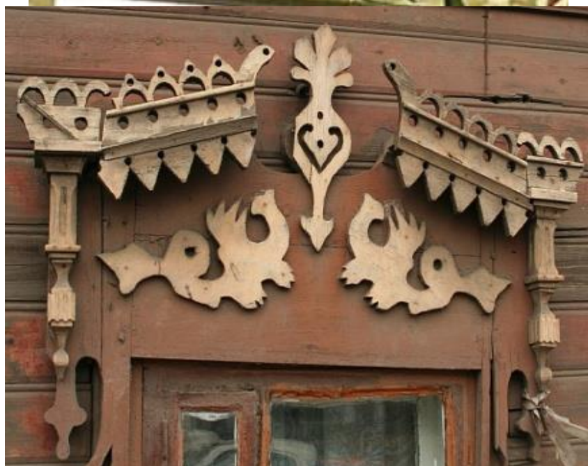
Костромская область. Обломихино. Ивановская область. Ярославская область
